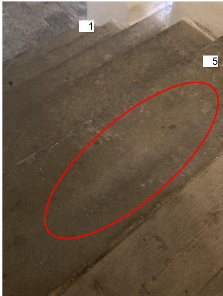
PROŠLAPÁNÍ VÝSTUPNÍCH A NÁSTUPNÍCH SCHODIŠŤOVÝCH STUPŇŮ - VÝMĚNA VIZ. POZNÁMKA
