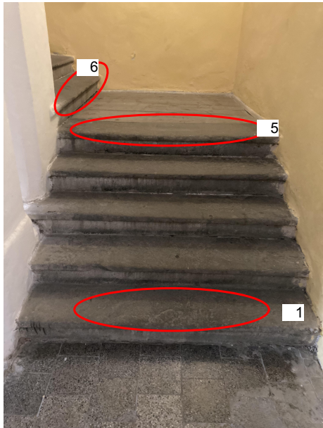
PROŠLAPÁNÍ VÝSTUPNÍCH A NÁSTUPNÍCH SCHODIŠŤOVÝCH STUPŇŮ - VÝMĚNA VIZ. POZNÁMKA
